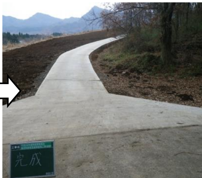
延焼対策としての恒久防火帯の整備
