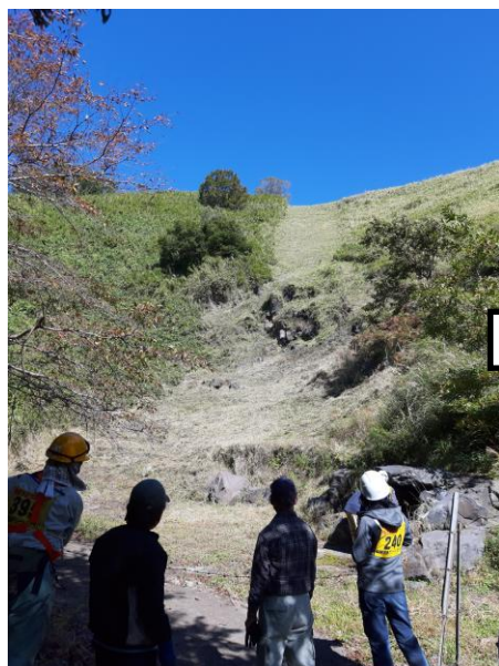
負担が大きい急峻な箇所での防火帯切り
